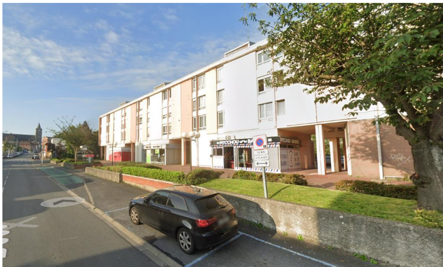
La copropriété du Pont Noir concerné par l'OPAH-RU avec volet copropriété
